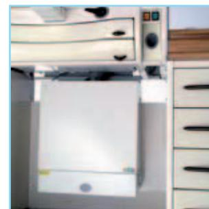
**3-** Inserire e far coincidere infine, la tubazione di aereazione alla bocchetta posta sotto il banco e fissarla con l'apposita fascetta.
